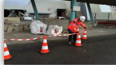
6. Rendre la zone d'intervention inaccessible le temps de la sécurisation et mettre le panneau de communication à l'entrée : « manipulation d'amiante en cours. Début de l'intervention / fin de l'intervention prévue : »
