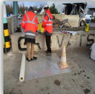
*\*En cas de vent, poser des cônes sur le polyane pour le fixer*
